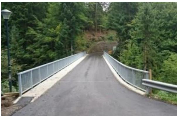
Nach Abschluss der Restarbeiten und insgesamt ca. 10 Wochen Bauzeit, konnte heuer die Sanierung der Bucherbachbrücke abgeschlossen werden. Die neue Tragschicht und die richtigen Wasserabläufe werden hoffentlich wieder einige Jahre den Anforderungen standhalten. Die budgetierten Baukosten wurden unterschritten und nach genauer Abrechnung werden die Zahlen veröffentlicht.
