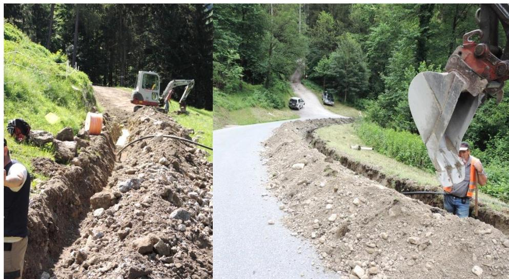
**1)** Lfm-Preis für Leitungs- bzw. Kabelverlegung einschließlich aller Erdarbeiten, unabhängig von der Geländeoberfläche (Asphalt, Schotter, Grünland)
